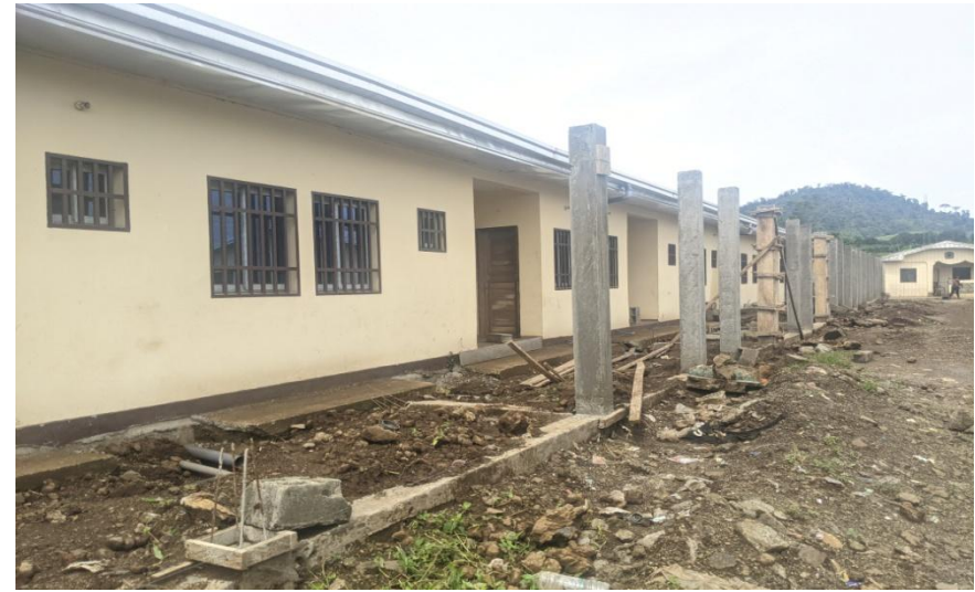
Côté logement, clôture en construction
