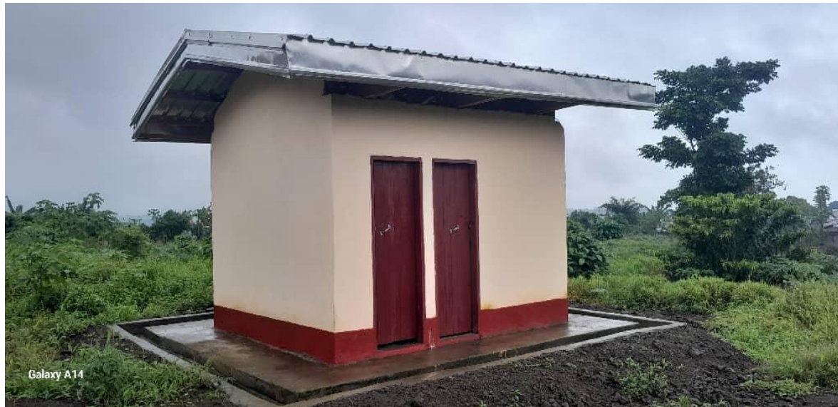
Bloc latrine EP Ngodi
