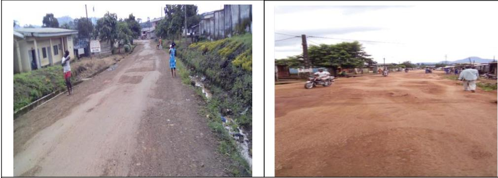
Photo 72 : Corps de la chaussée en très mauvais état/ Caniveaux en mauvais très mauvais état/ absence d'entretien sur les fossés enterre
