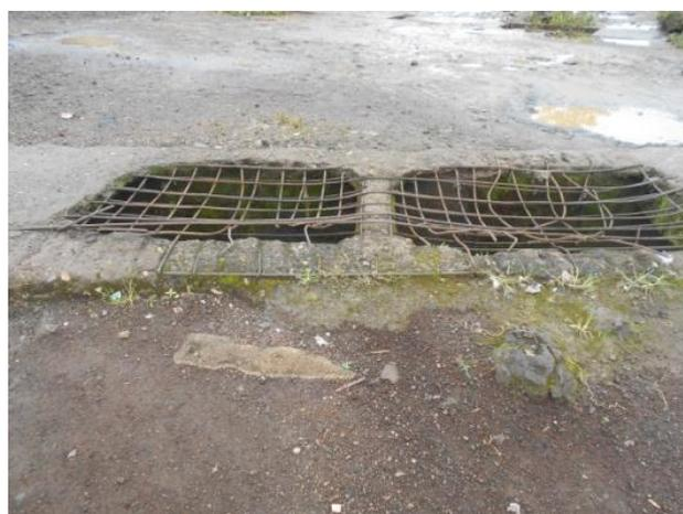
Photo 20 : Exposition de fer à béton, potentiel danger par un dalot dégradé au quartier Etape.
