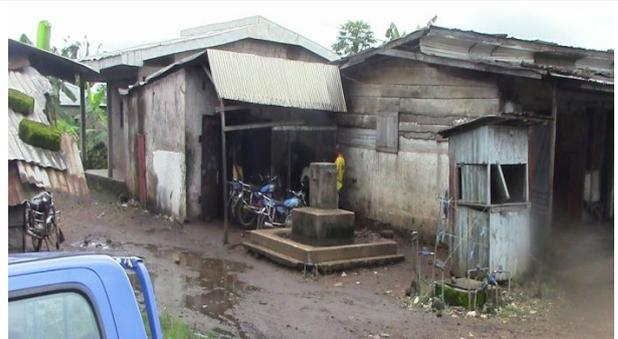
Photo 36 : Maison semi-dure avec les vieilles tôles à Loum chantier Sie (côté stade)
