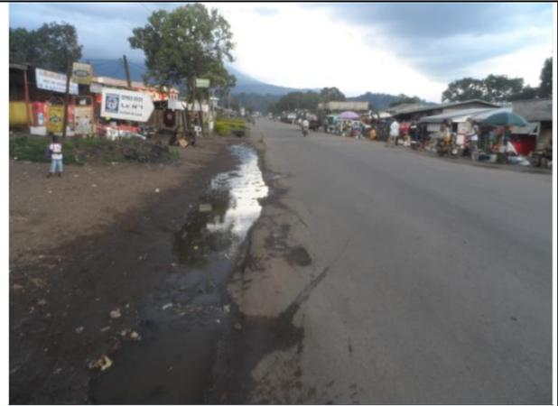
Photo 71 : Pas de signalisations routières /encombrement le long de cet axe par les vendeurs/ dégradations sur les accotements
